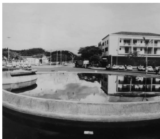
Foto 20: Detalhe da Fonte original
